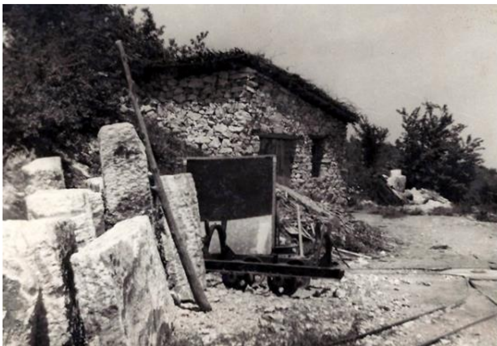
Figura 2.13 - Piccolo edificio adibito a magazzino davanti al quale si trovano dei binari, che si snodano (come si può notare in basso a destra) in almeno due direzioni. Immagine cortesia Sig. G. Monge.
