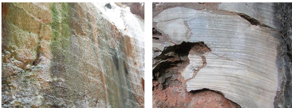
Figura 2.17 - Risultato dell'isolamento dei blocchi mediante l'utilizzo di macchinari: si osservano scanalature parallele particolarmente fitte e con andamento regolare.
