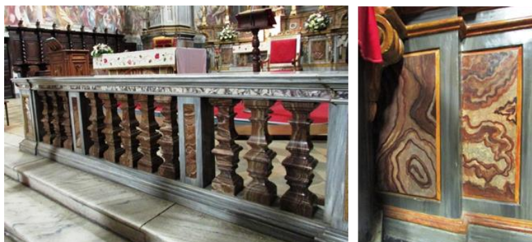
Figura 5.17 - A sinistra i pilastrini della balaustra e a destra un riquadro dipinto a imitazione.
