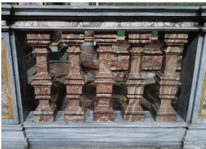
Figura 5.8 - Una porzione di una delle balaustre che separano gli altari delle cappelle laterali dalla navata centrale. Anche in questo caso i pilastri, seppure di sezione meno elaborata, sono ricavati il più possibile da blocchi monolitici.
