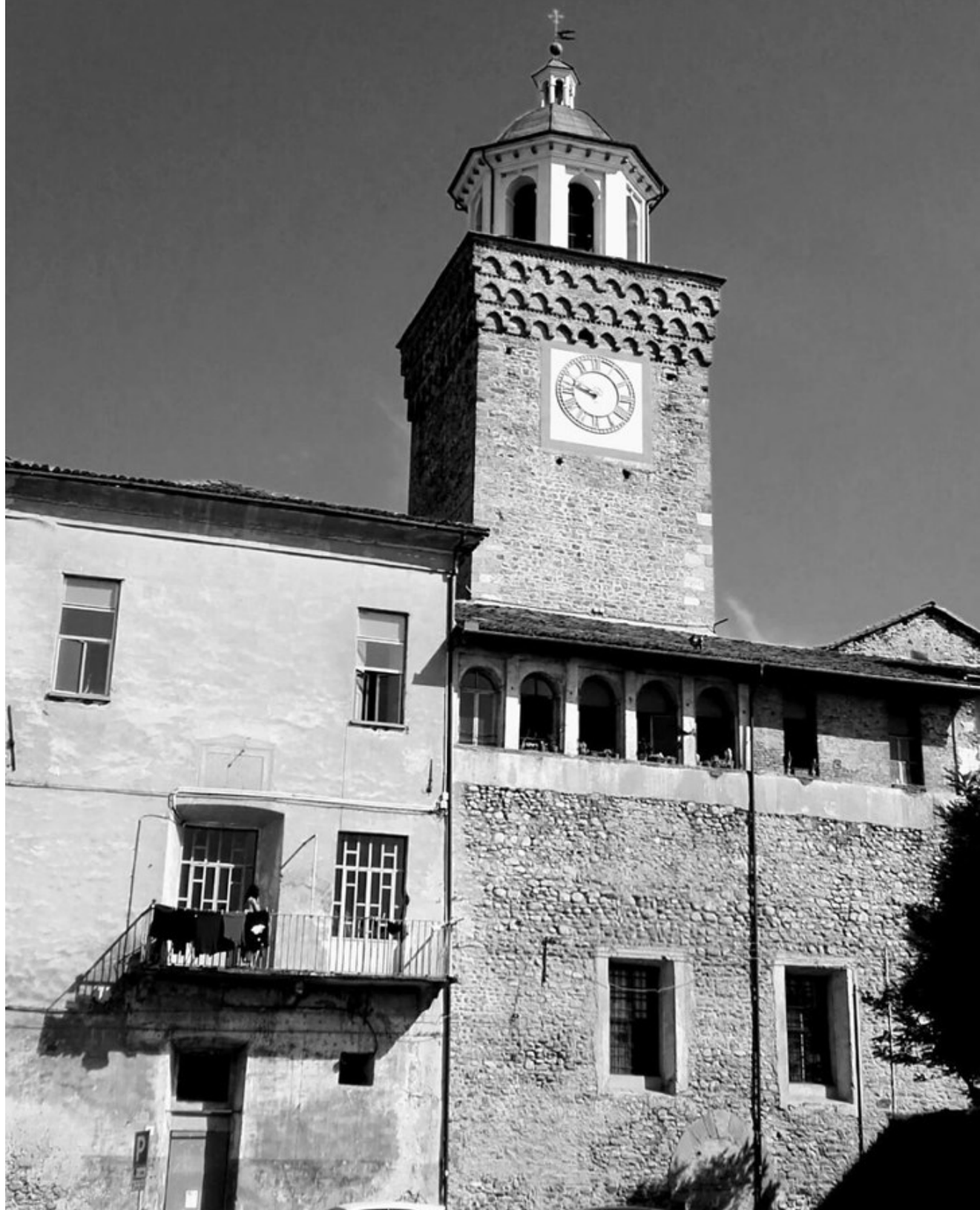
Figura 1.2 – Il torrione del Castello Inferiore che oggi costituisce il campanile della Chiesa della Confraternita SS. Trinità di Busca.
