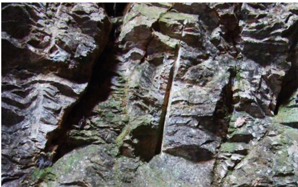
Figura 2.15 - Esempi delle tracce lasciate dall'uso delle barramine e dagli esplosivi (campo inquadrato 1,5 m circa).
